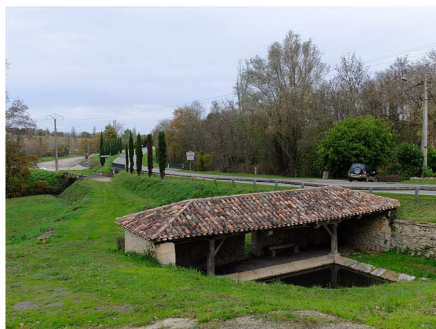
Le lavoir de Saint Romain, récemment rénové
