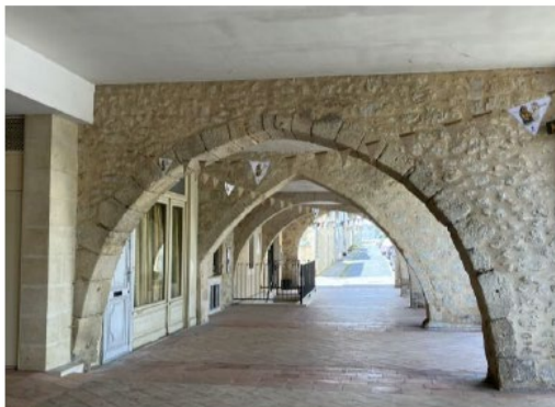
La Halle sous les arcades
